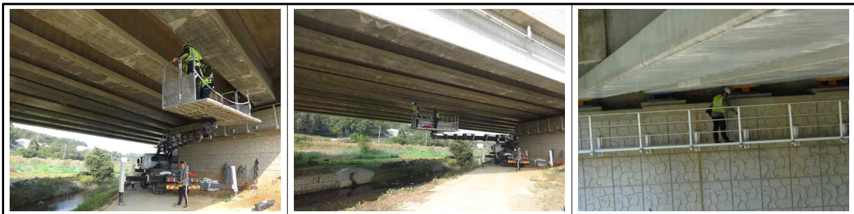
[고소작업차를 이용한 근접조사 실시]
